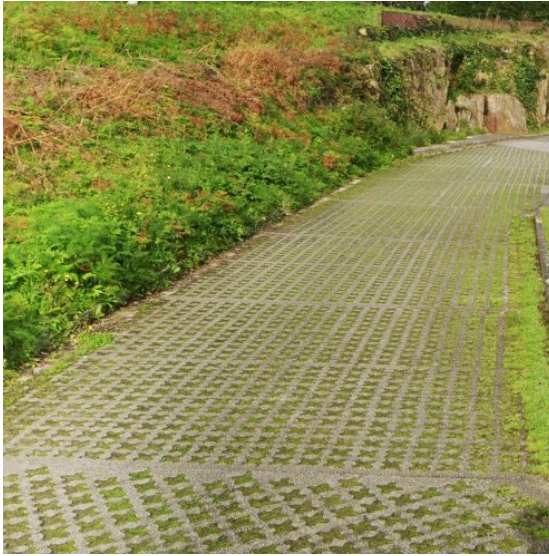
Ejemplo de pavicésped de hormigón in-situ y de césped armado con retícula de polietileno
