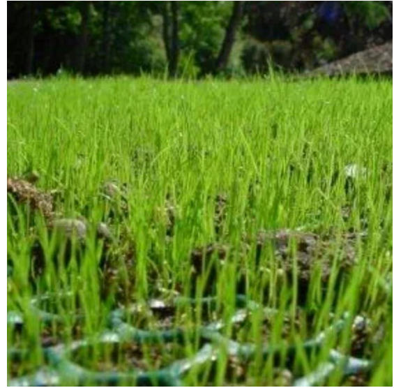
Ejemplo de pavicésped de hormigón in-situ y de césped armado con retícula de polietileno
