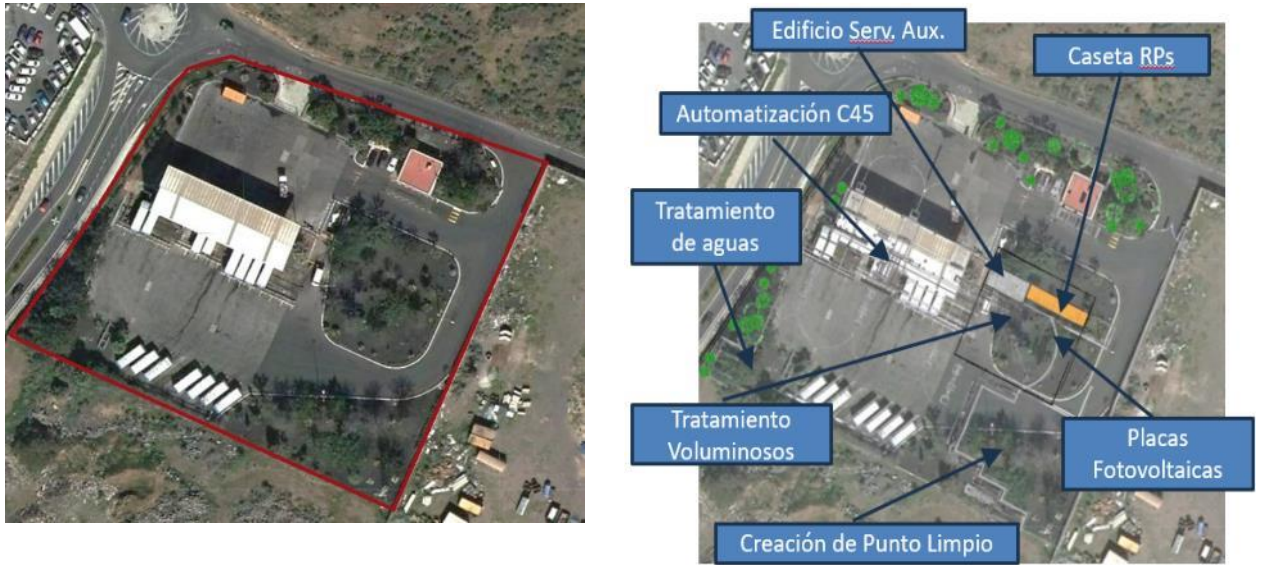
Figura 9. PT-3: Arona. Estado actual y reformado. (Cabildo de Tenerife)
