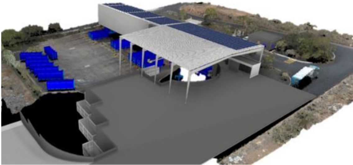
Figura 10. PT-3: Arona. Estado reformado. (Cabildo de Tenerife)
