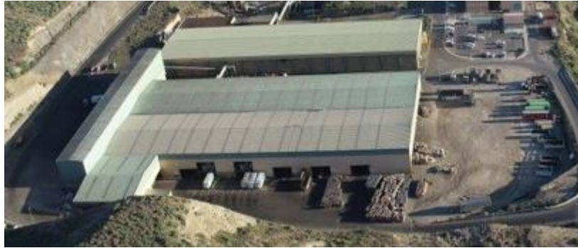
Figura 21. CAT: Vista aérea de Planta de Tratamiento Mecánico - PTM. (Cabildo de Tenerife)
