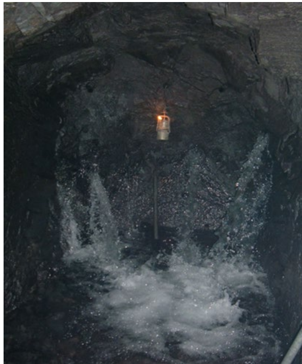
Contacto de la galería con el acuífero
