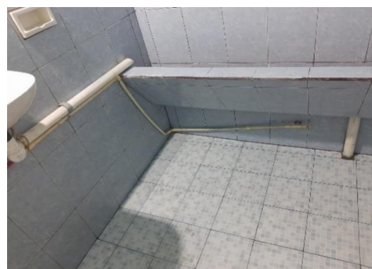
Figura 7: Adaptación de PVC A caja de WC.
