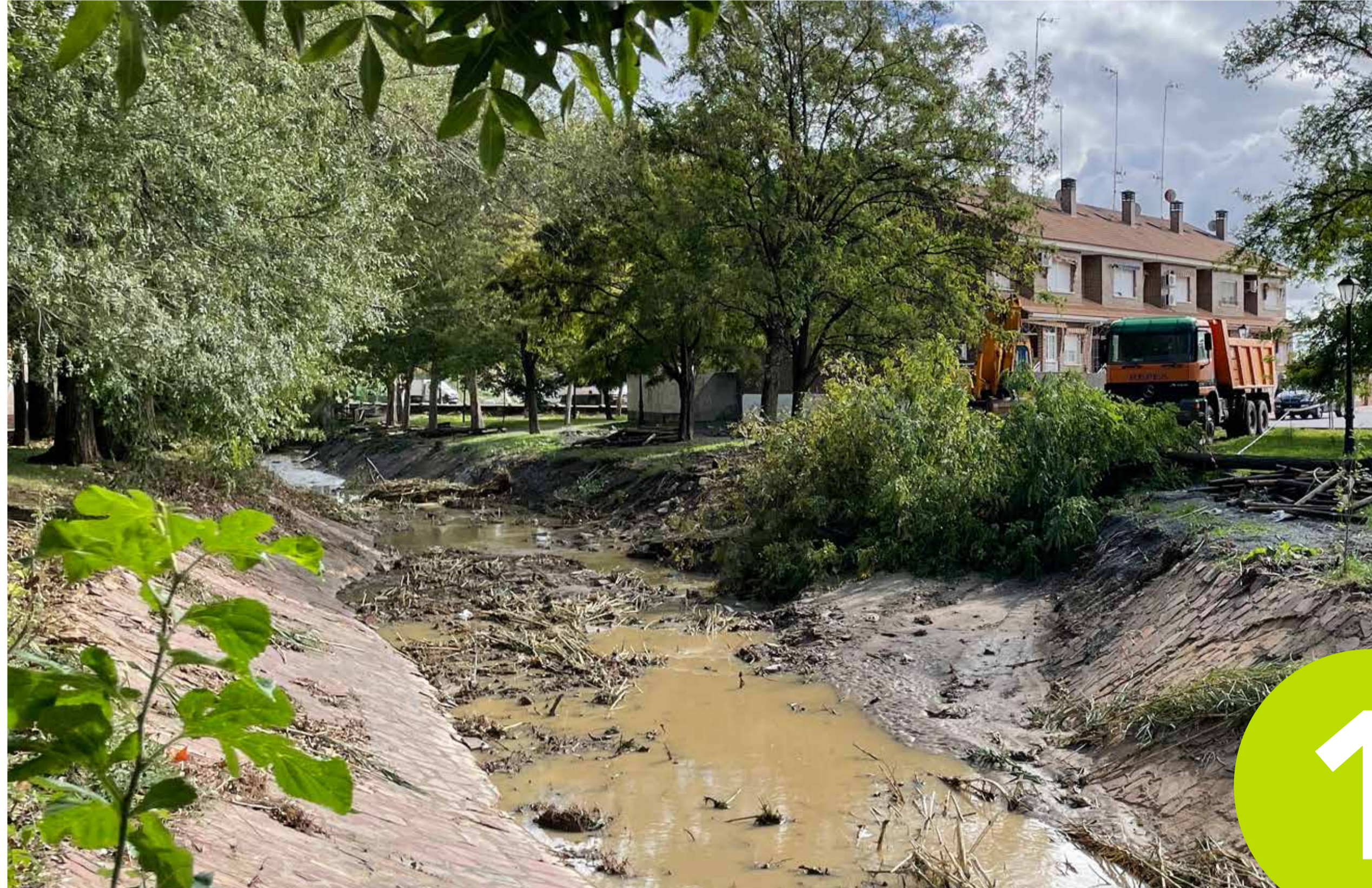
Estado previo a demolición y retirada de enchachado. OCT.2023 (Foto: Luis Montenegro Lafont)
