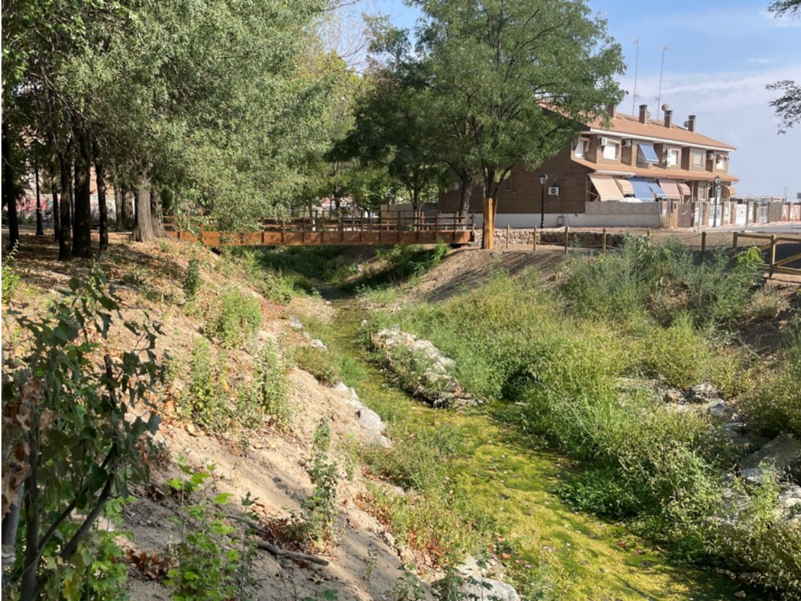
Estado post-operacional a 3 meses de intervención (Foto: Luis Montenegro Lafont)
