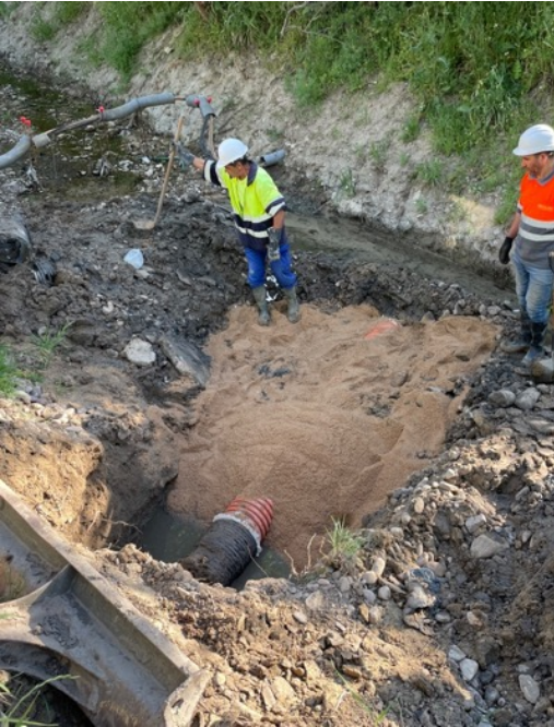
Reparación tubería saneamiento.
