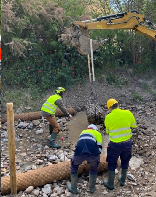
Instalación de gaviones flexibles. (Foto: Caroline Heredia)
