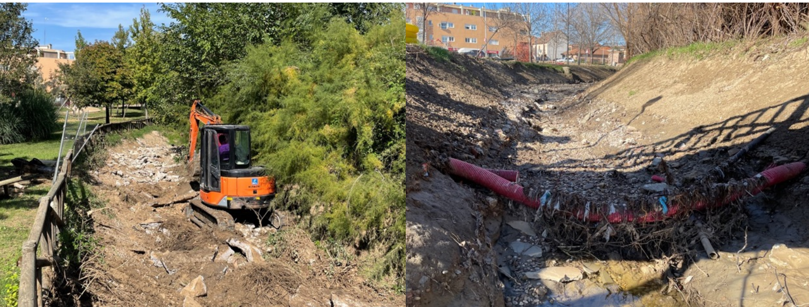
Inicio trabajos demolición en arroyo el Cubo.
