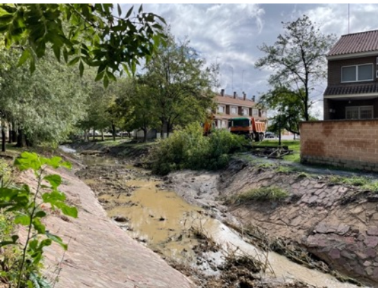
Inicio de trabajos demolición.
