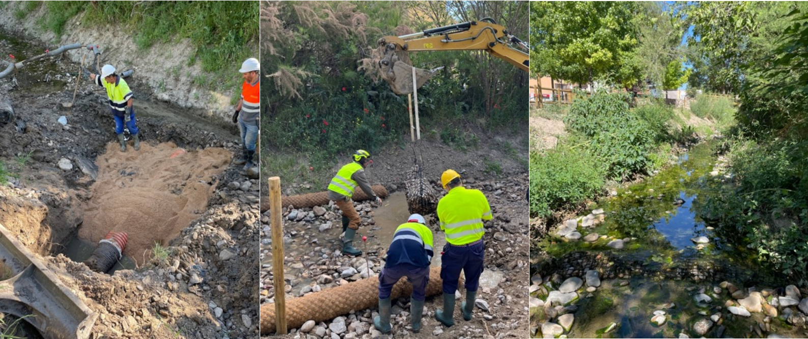
Reparación tubería saneamiento.
