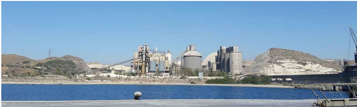
Figura 1. Planta de Holcim en Carboneras (Almería). El 100% del agua dulce empleada en la producción de cemento proviene de la desalación 2 .
