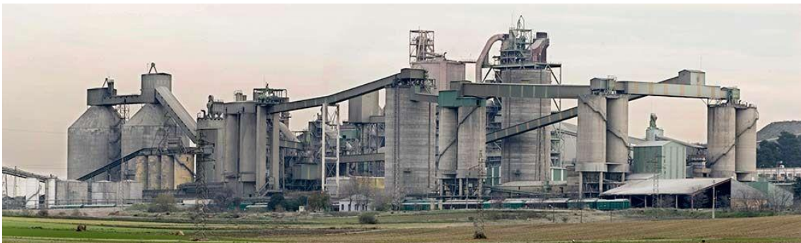
Figura 2. Planta de Holcim en Villaluenga de la Sagra (Toledo). El 100% del agua consumida para uso industrial en esta planta procede de la regeneración de aguas residuales 6 .
