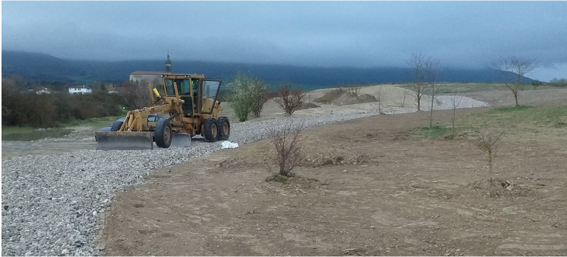
Figura 5. Empleo de áridos reciclados en la subbase de un camino
