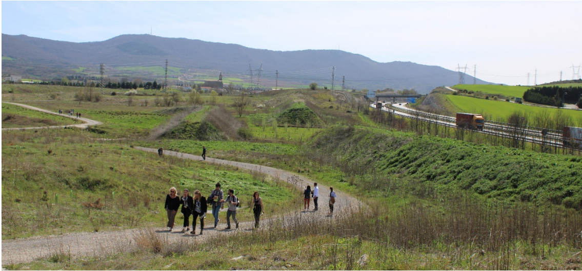
Figura 4. Diques sonoros frente a la A-1 ejecutados con tierras recicladas (Fase II). (CEA)
