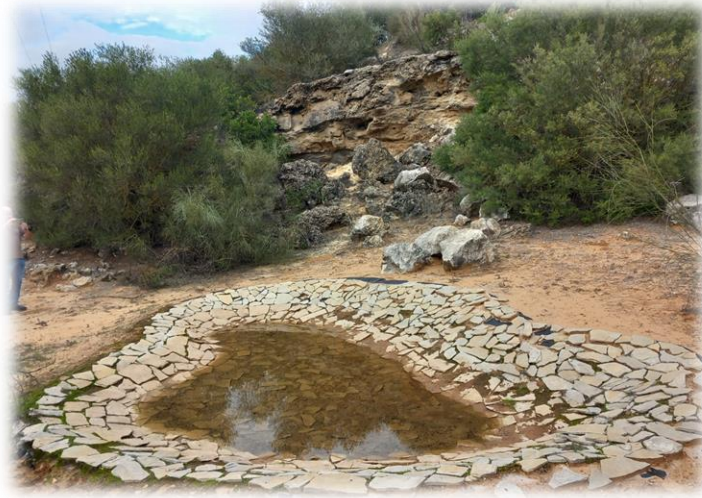
Figura 34. Pequeña charca artificial, construida sobre geotextil (Holcim).
