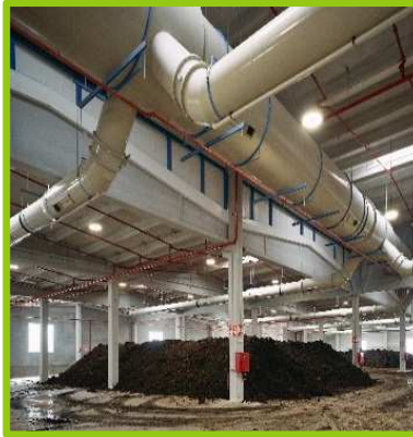
Nave maduración de la PCA
