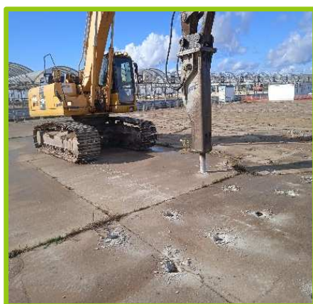
Figura 2. Trabajos demolición eras de hormigón (EMASESA)
