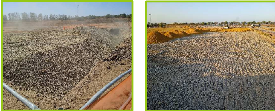
Figura 6. Trabajos de extendido en tongadas del árido reciclado (EMASESA)
