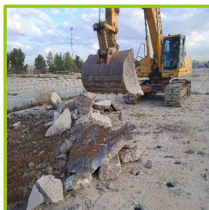
Figura 2. Trabajos demolición eras de hormigón (EMASESA)
