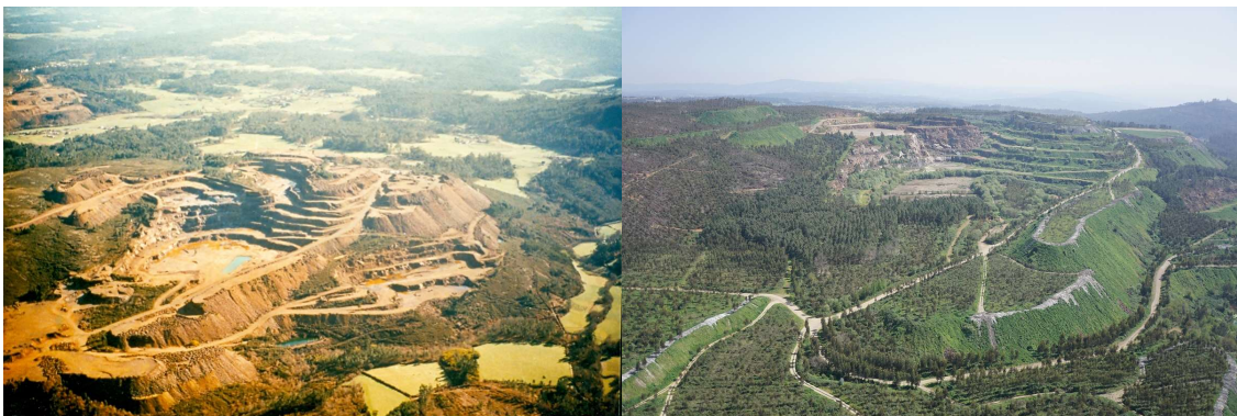
Detalle de foto área de la Mina de Touro en 1998 y en 2023 (Fuente: TEN)
