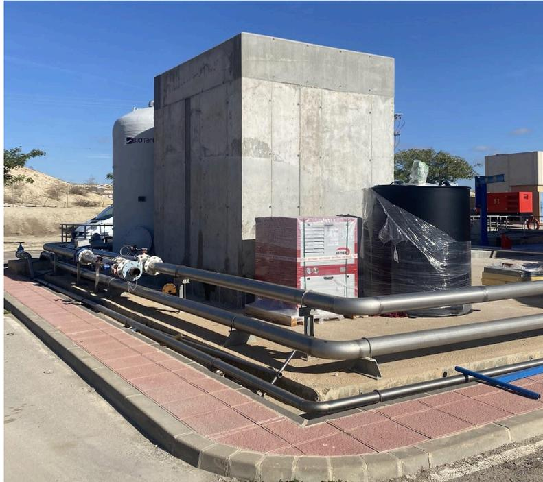
**Figura 3.** Estado de las instalaciones en la EDAR Nueva Sucina. Nueva Sucina: Estructura de membranas, soplante y tanque de limpieza química.
