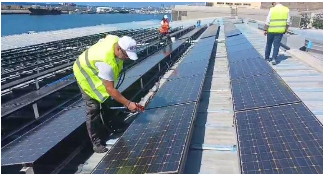
Figura 5. Proceso de imprimación mediante pistola pulverizadora por técnicos especializados de FOTOCAN.
