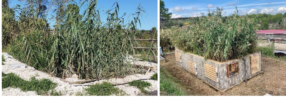
Figura 2. Imágenes de los humedales demostrativos construidos en la EDAR de Carrícola. Humedal de flujo subsuperficial vertical 1 (izq.) y 2 (dcha.) conectados en serie, ambos con fango de ETAP.
