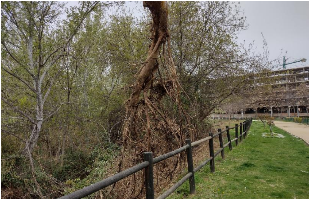
Figura 8. Eliminación de restos del interior del cauce en la primera zona de actuación (parque Alcalde Jesús Pérez)
