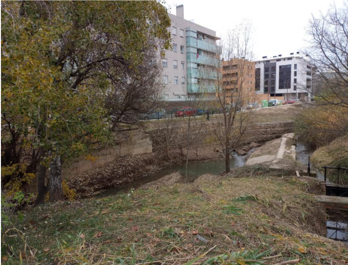
Figura 16. Estado del azud en 2022 inmediatamente después de la limpieza.
