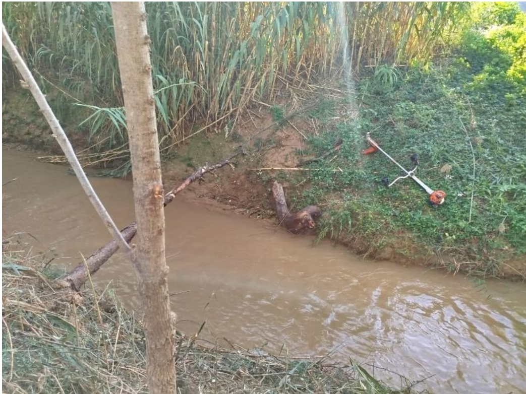
Figura 9. Eliminación de obstrucción en el cauce en el tramo 2
